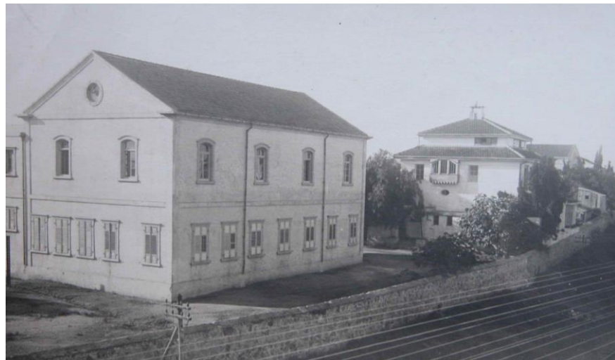
בית טמפלרי לאורך מסילת הרכבת יפו ירושלים: חלונות ממוסגרות במסגרות בטון טרומי עיבוי פינות והבלטת טיח בין הקומות להגנה על הרלסים-מקור השראה לתושבי אחוזת בית.
