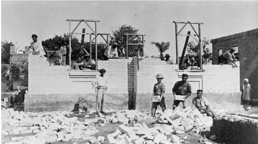
תצלום החושף את טכנולוגיית הבנייה: מסד בולט מבטון, קירות נושאים מלבני סיליקט ללא עמודי בטון, בליטות ושקיעות בעובי הקיר כדי להשיג נישות וקרניזים, מסגרות עץ סמויות מסביב לפתחי החלונות כדי לתמוך את הקירות ולפזר את הכוחות האנכיים
